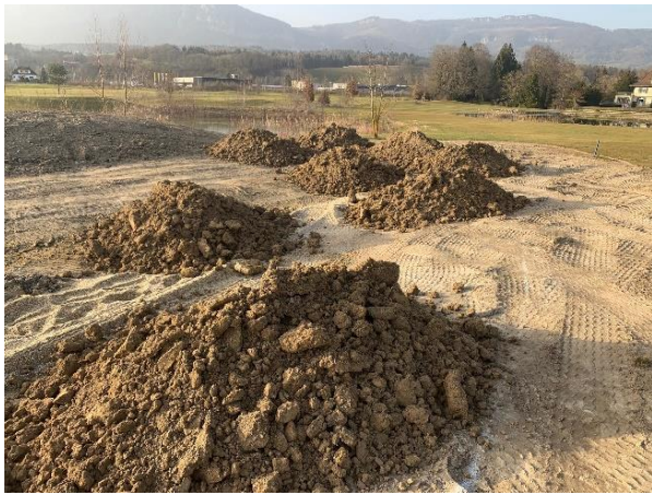
Renaturierung Bunker Bahn 2
