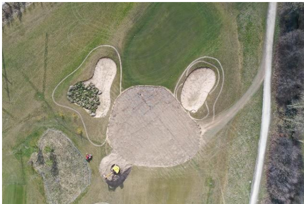
Neubau Vorgreen 1 und Bunkersanierung
