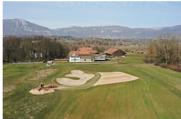
Neubau Vorgreen 9 mit Bunkersanierung
