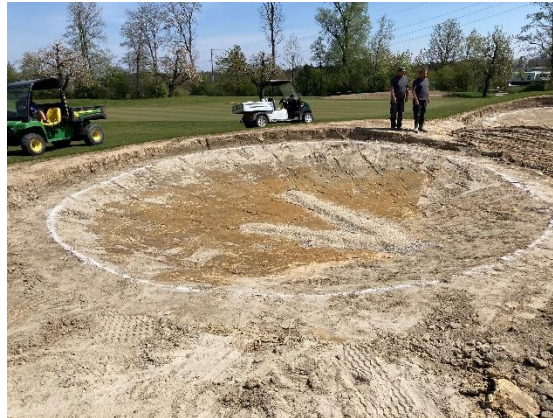
Modellierung abgeschlossen mit Drainage
