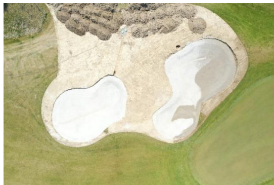
Bereit zum Einbau Bunker-Blinder (Gummigranulat)
