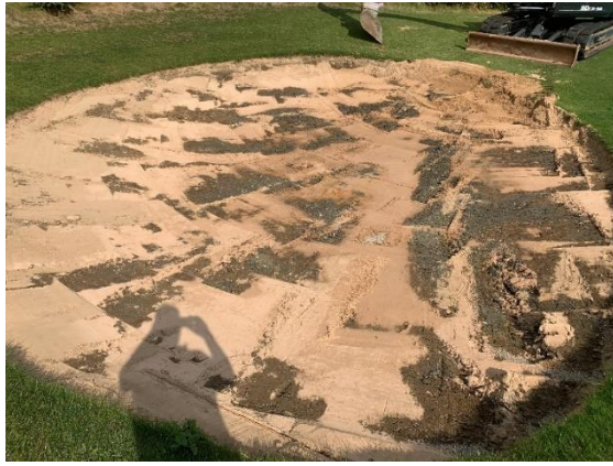
Aushub Sand und lehmige Bunkersohle
