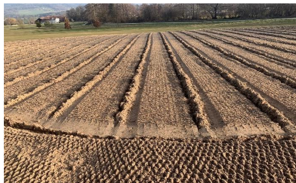
Vorgreen 1 vorher, 10 cm A-Boden auf Lehm, nachher 40 cm Rasentragschicht mit Drainage
