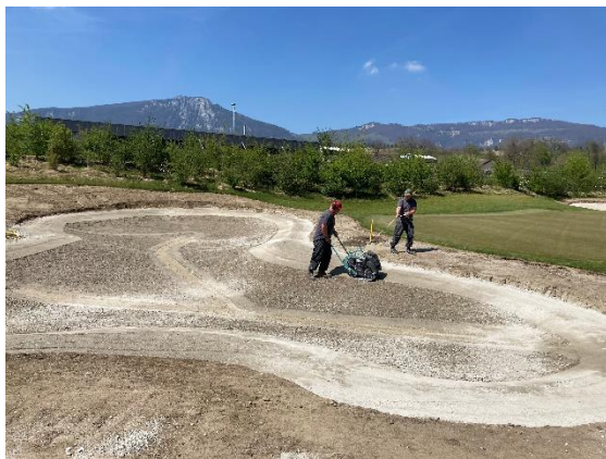
Planierung mit Vibraplatte
