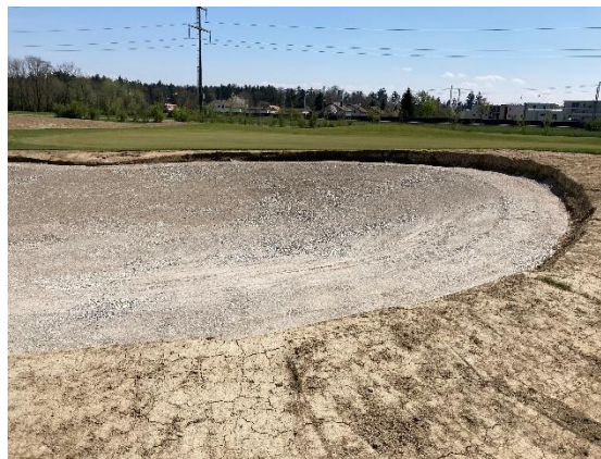
Bereit zum Einbau Bunker-Blinder (Gummigranulat)
